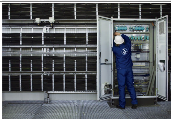
Elektroniker/-in für Betriebstechnik:
